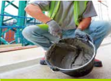
Mix Masonry Mortar
